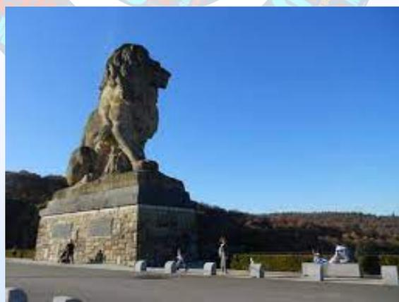
Le lion comporte 183 blocs, pesant jusqu'à 7 tonnes pièce ; il développe 13,50m de hauteur, 16m de longueur et 5m d'épaisseur, ce qui représente 130 tonnes de pierres. Durant l'été 1970, ce lion fut précautionneusement démonté par sciage des joints, puis réédifié au faite du nouveau barrage : l'entreprise avait demandé 40 jours de travail ...
