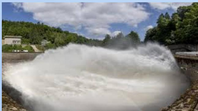
Deux canalisations de vidange utilisent les anciennes galeries construites à cet effet : elles se développent sur 380m en rive droite et 520m en rive gauche. On y a posé des tuyaux d'acier, dont le diamètre varie de 1,80 à 2,20m, et qui peuvent évacuer 89m<sup>3</sup>/seconde. Il faut donc plus de 4 jours pour vider le lac, mais 37 heures suffisent pour éliminer 10 millions de m<sup>3</sup>, équivalant à 40% de la réserve ; leur évacuation fait baisser de 10m le niveau de l'eau du lac.
